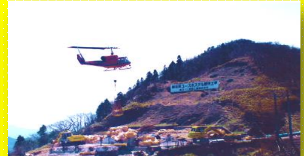
■ 日本初、ヘリコプターを使用してのホテル解体工事
