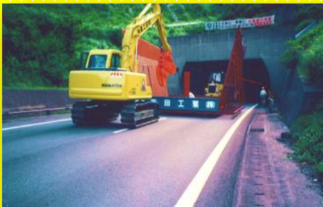
■ 独自特許技術によるトンネル天井板撤去解体工事
